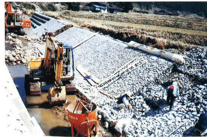
③ 護岸工かごマット 詰石状況
