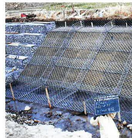
② 護岸工かごマット 布設
