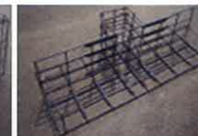
ガードレール基礎用鉄筋
