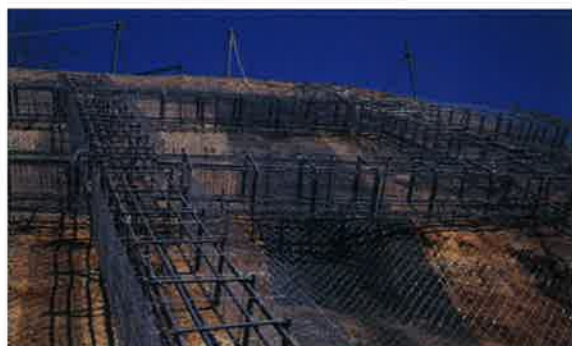
(クリンパ金網・亜鉛メッキ鉄線 JIS G3547 線径2.3mm 網目 29×16mm) スターラップ筋対応のKPタイプの製造も対応出来ます。
