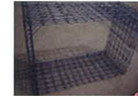
貯水槽用鉄筋
