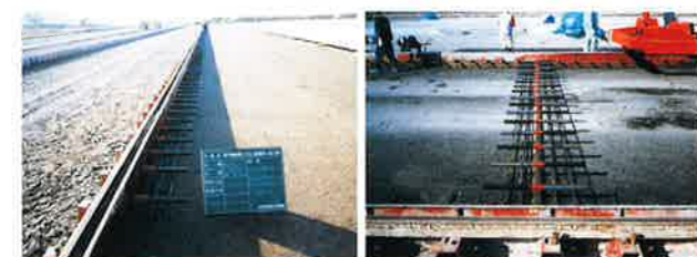
縦目地の設置状況
