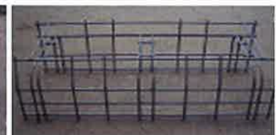
護岸基礎用鉄筋
