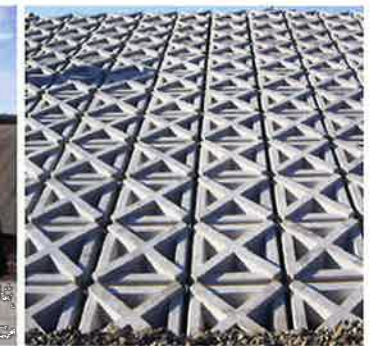
ブロック連結金具を使用した河川
