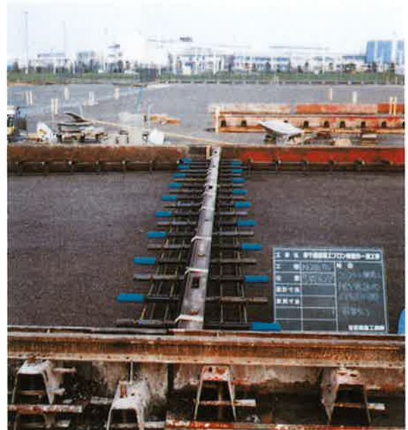
横膨張目地の設置状況
