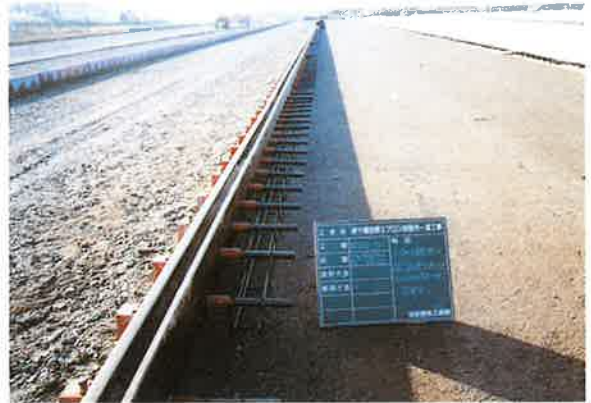
縦目地の設置状況
