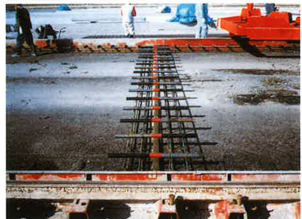
横収縮目地の設置状況
