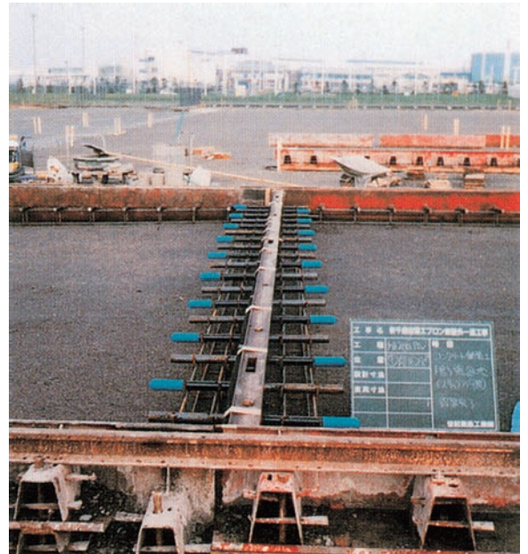
横膨張目地の設置状況
